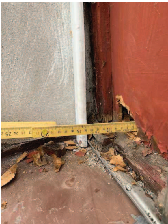
Pohled na provedeno sondu do meziokenní vložky.
