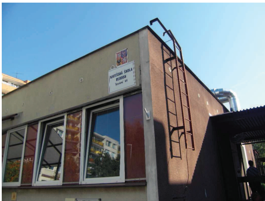
Pohled na detaily stávající fasády s původními meziokenními vložkami krytými sklem
